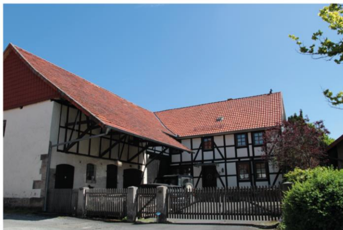
Objektkarte Nr. 24 - Dorfgregion Dramfeld, Obernjesa & Sieboldshausen Dramfeld, Hauptstraße 23 - Hauptgebäude
