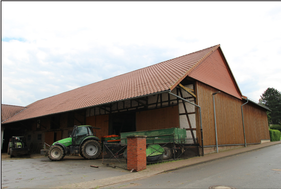
Abb. 25: Gebäudewetterseite mit Tonziegel- und Holzbehang
