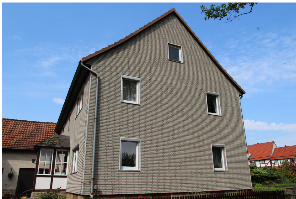
Abb. 37: Überprägtes Gebäude mit vorgesetztem Kunststoffbehang in Klinker-Optik Foto: NLG 2023
