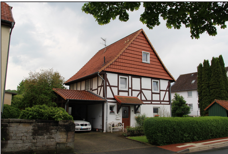
Abb. 26: Giebeldreieck mit Tonziegelbehang
