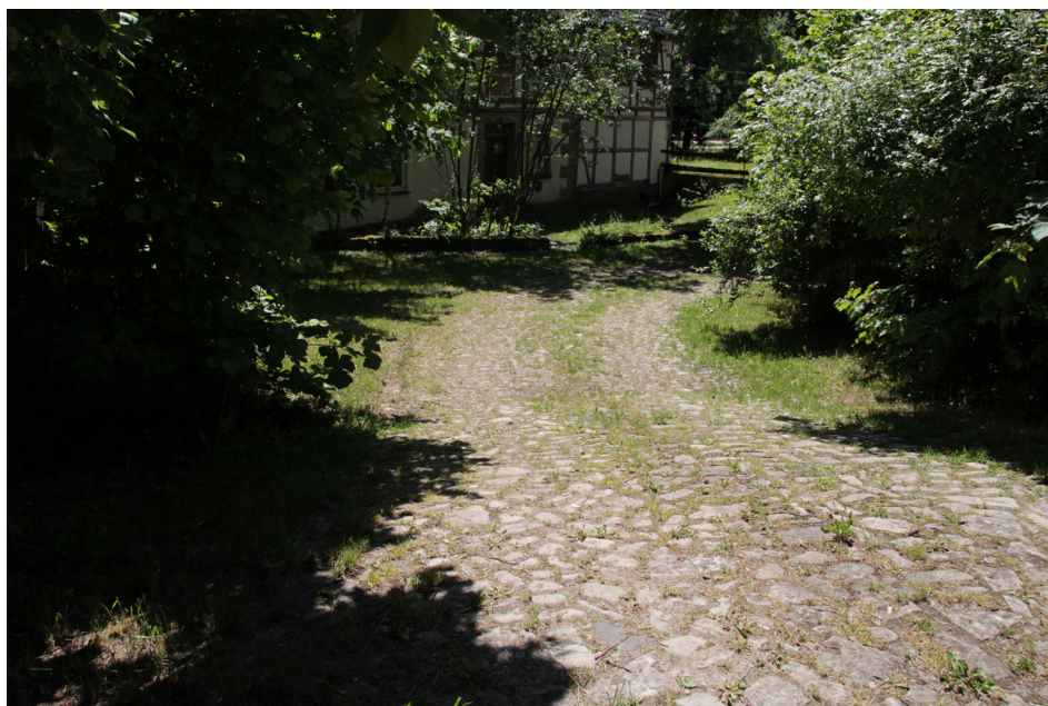
Abb. 32: Historische Grundstückseinfahrt mit Natursteinpflasterung
