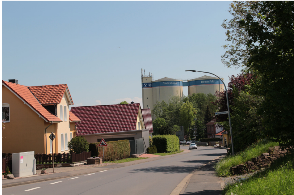
Abb. 71: Markante Zuckersilos des VR-Bank Zentrallagers in Obernjesa
