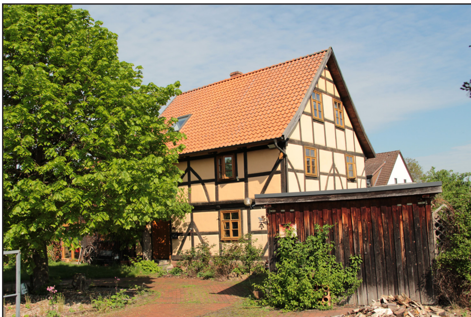
Abb. 22: Zweistufiges Fachwerkgebäude mit Satteldach und Lehmgefachen
